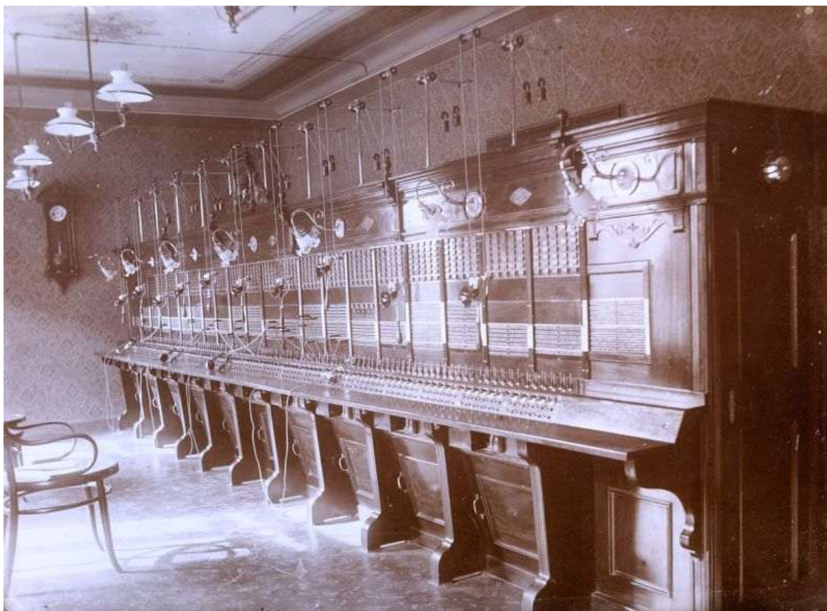
Slika 5. Prva zagrebačka državna induktorska telefonska centrala puštena u promet 9. travnja 1895. koja je služila sve do 1904. godine
