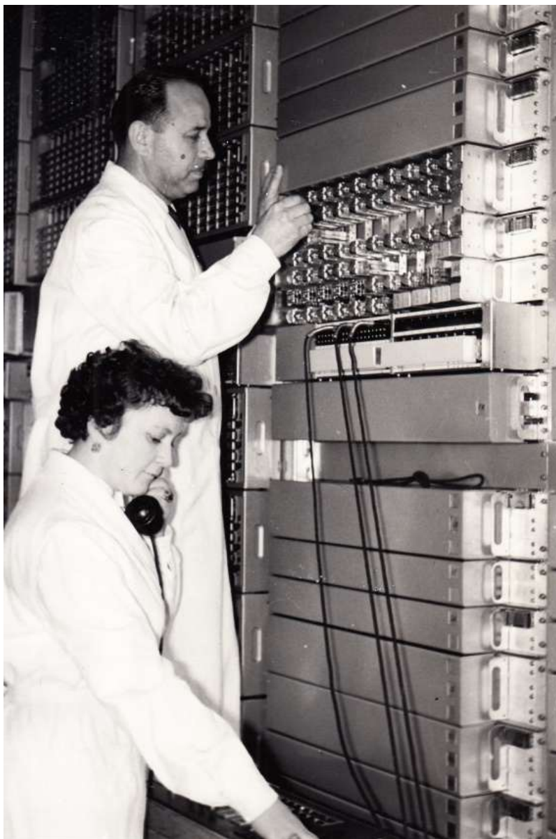
Slika 20. Ispitivanje ATC-a „Peščenica“ u radu 1955. godine, dok su u pozadini vidljivi karakteristični koordinatni birači prve automatske telefonske centrale ARF-50. Na fotografiji se nalaze gospođa Vera Papišta i gospodin Martin Crnjaković.
