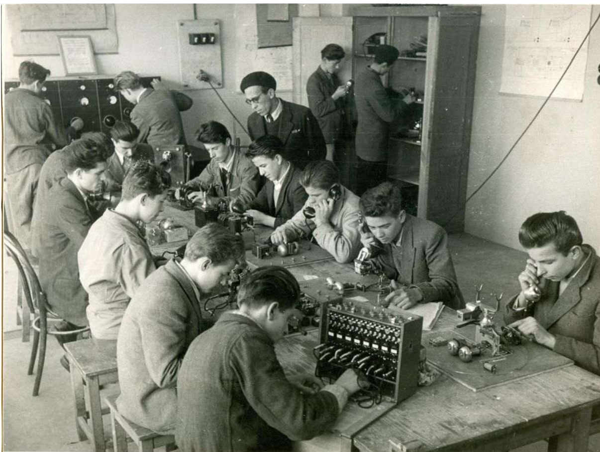
Slika 15. Polaznici Industrijske telegrafsko-telefonske škole mehaničarske škole oko 1950. godine upoznaju se s osnovama telefonije (na fotografiji vidljivi telefonski induktori, improvizirani automatski telefonski aparati na drvenoj podlozi te ručna induktorska telefonska centrala vojnoga tipa kapaciteta 8 brojeva)
